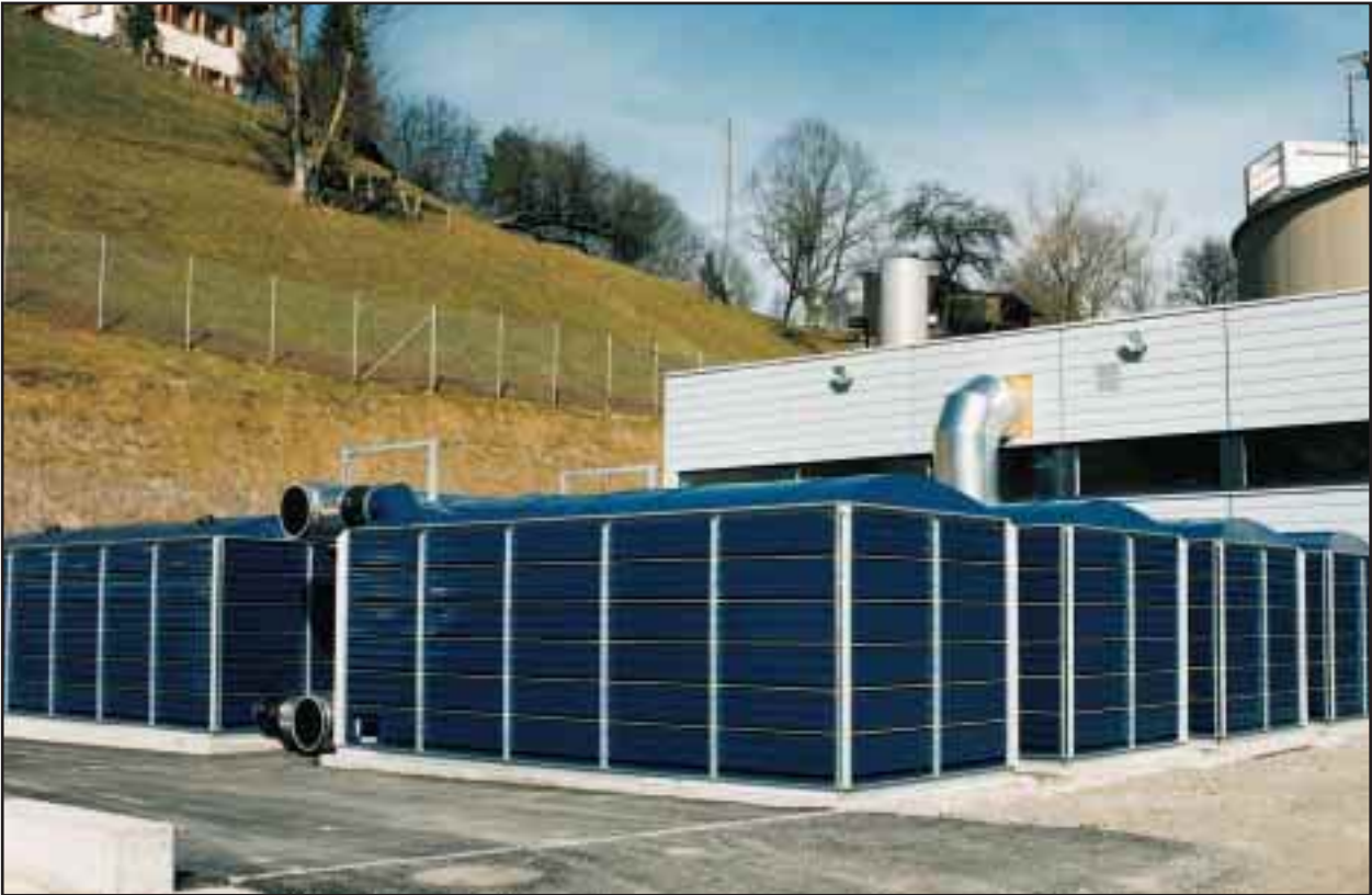
Oben: Konventionelle Biofilteranlage für 50.000 Nm 3 /h Abluft
