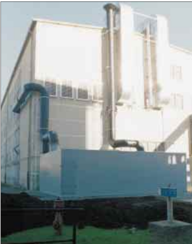
Unten: Biofilteranlage nach dem BIOSORP-Verfahren für 10.000 Nm 3 /h Abluft
