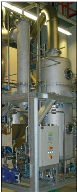
**Strahlgaswäscher zur Abtrennung brennbarer Stäube**
